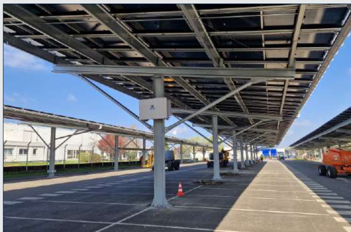
Carporturi Fotovoltaice | Franta • 600 tone structuri metalice
