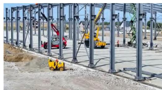
Imagine din timpul montajului structurii metalice
